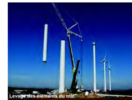
Levage des éléments du mât
