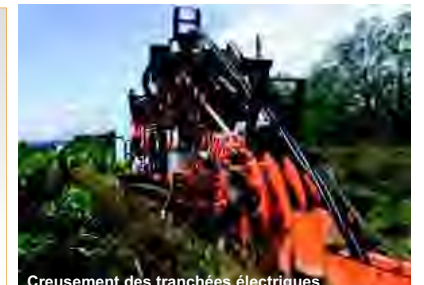
Creusement des tranchées électriques
