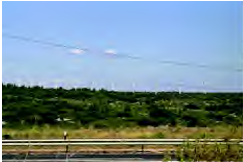
Figure 9 - Photographie du parc éolien réalisé
