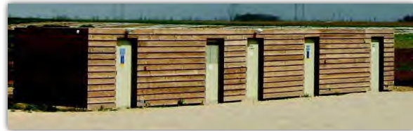
Exemple d'un poste de livraison
